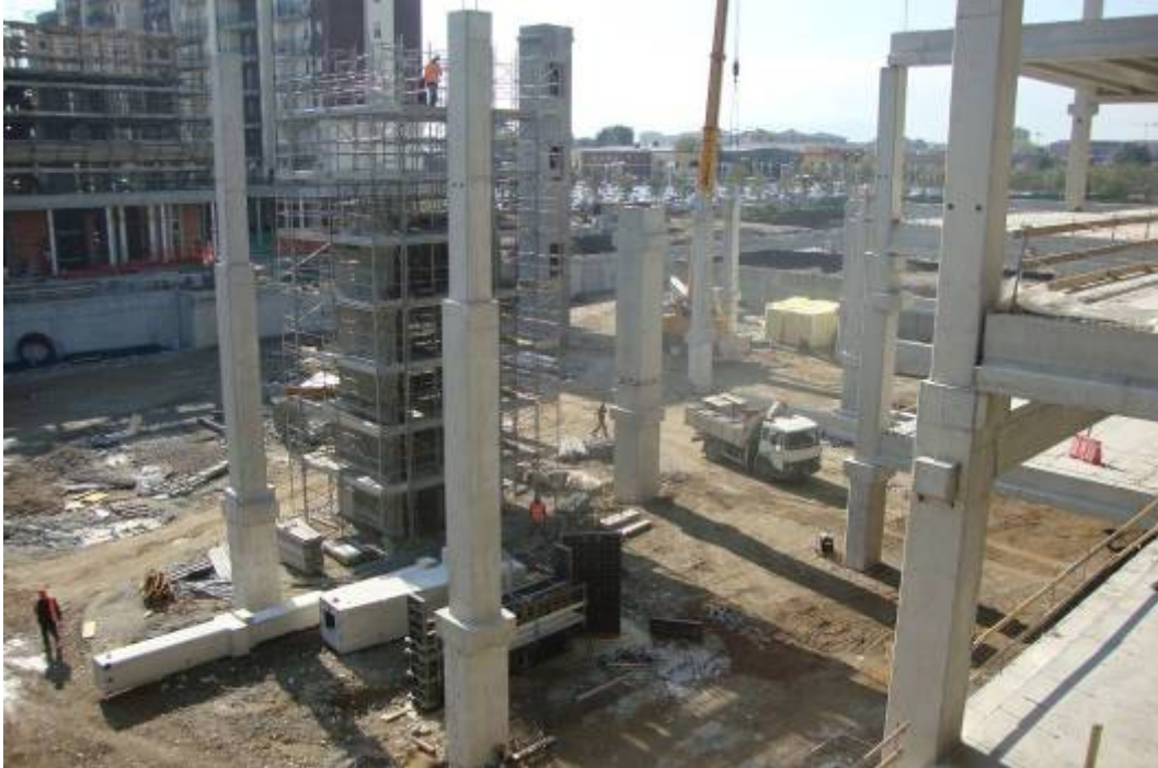
Collegno - centro commerciale prefabbricato c.a. e c.a.p. - 50'000 m 2 - anno 2013
