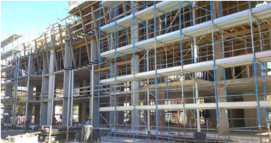
Fossano - edifici multipiano con solette a piastra 6'000 m 2 - anno 2015
