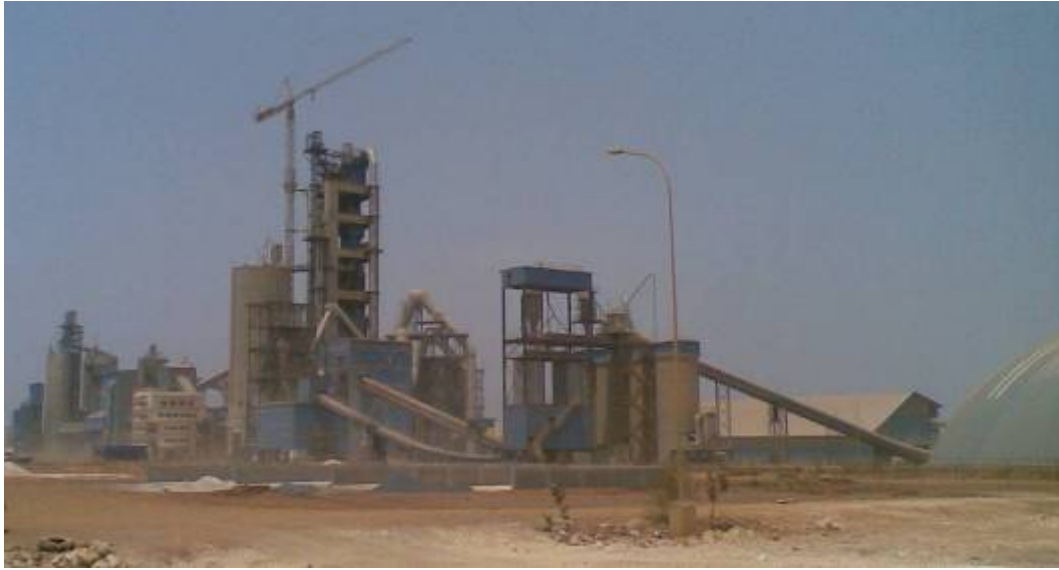
Les ciments du Sahel S.A.- Cimenterie de Kirene
